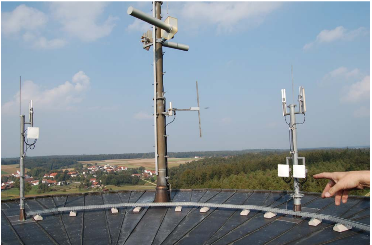
Die Antennenanlage auf dem Wasserturm in Neukreith
