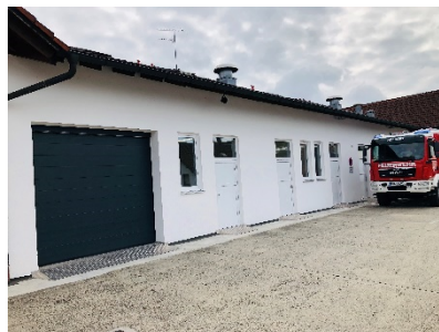
Betriebsgebäude für die FW
