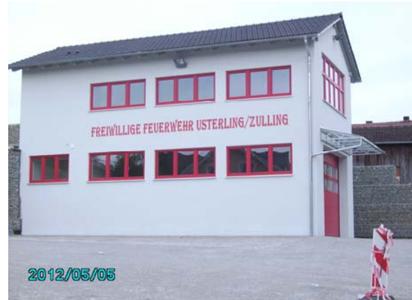
Neubau Gerätehaus FF Usterling-Zulling
