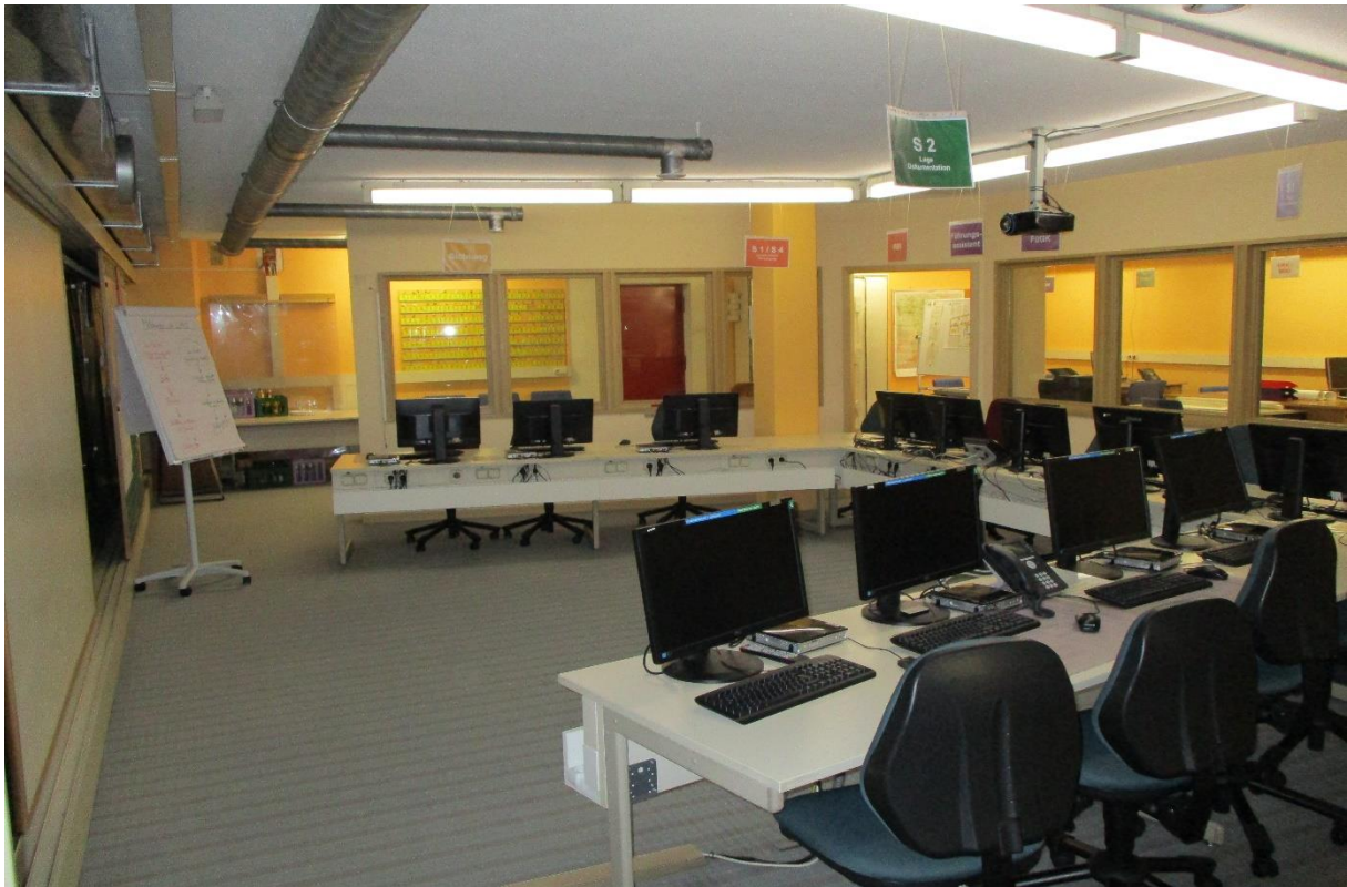
FüGK-Raum im Landratsamt Dingolfing-Landau
