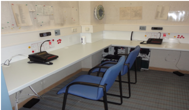
Funkraum der KomFü nach Umbau auf Digitalfunk
