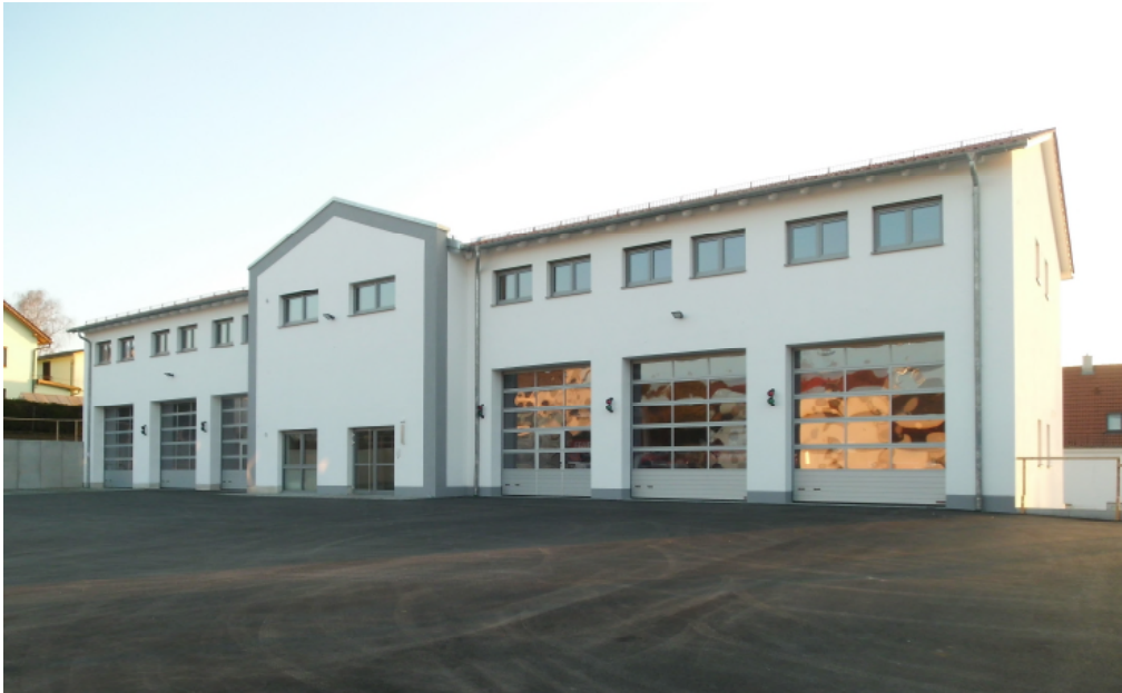
Neubau Gerätehaus Mengkofen
