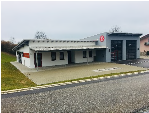
Gerätehausneubau FF Wolfsdorf-Fichtheim
