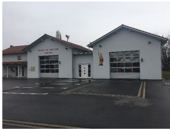
Gerätehauserweiterung FF Haidlfing
