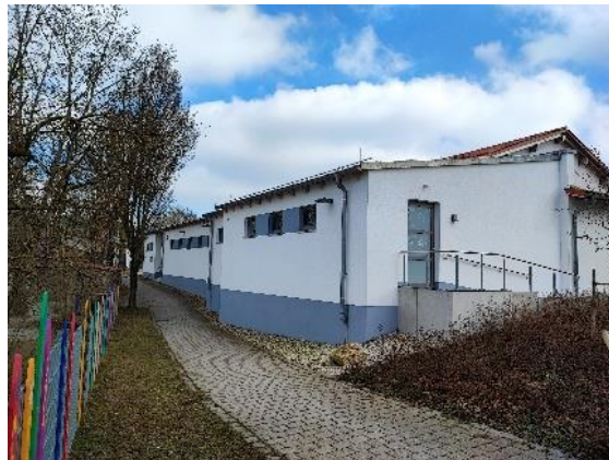
Gerätehauserweiterung FF Reisbach
