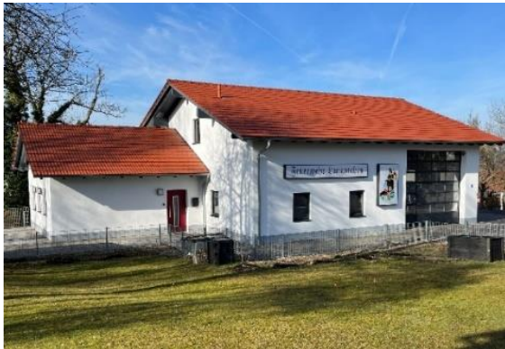
Gerätehauserweiterung FF Langgraben
